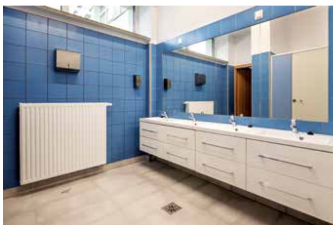
Modernizacja dotarła do najdalszych zakamarków hali sportowej. Przebudowano toalety, szatnie, magazyny sprzętu, itp.
