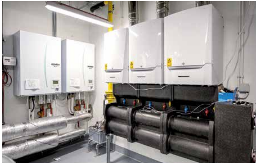
Kotłownia wyposażona w ekologiczne pompy ciepła wspomagane kotłami gazowymi.
