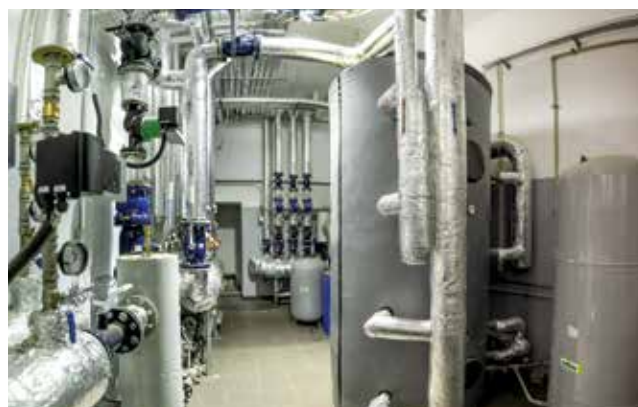
Po remoncie w starej kotłowni znajduje się rozdzielnia i zasobniki ciepłej wody użytkowej.
