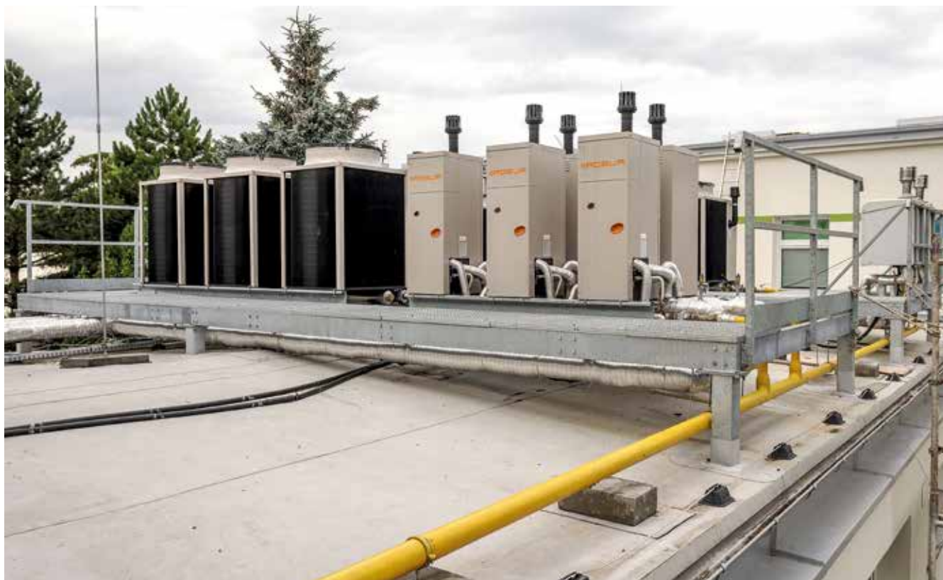
Nowa „kotłownia”, czyli pompy ciepła (czarne) i kotły gazowe (beżowe) na dachu budynku. Żółta rura biegnąca z boku to zasilanie gazem całego kompleksu grzewczego.
