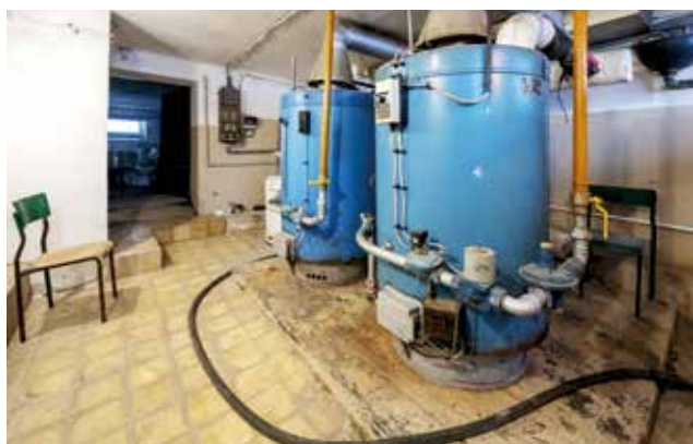
Tak wyglądała szkolna kotłownia przed remontem, kotły gazowe były mocne, ale nie oszczędne.
